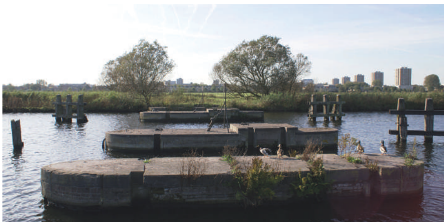
Enkele pijlers met schotbalkspinningen van de damsluis in de Ringvaart bij Vijfhuizen.
