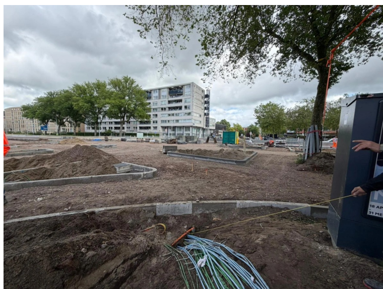
Het trekken van kabels voor stoplichten.
